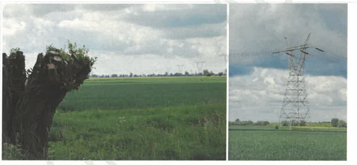
Fot. 20.; Fot. 21. Linie wysokiego napięcia pomiędzy Gniazdowem a Nową Cerkwią
