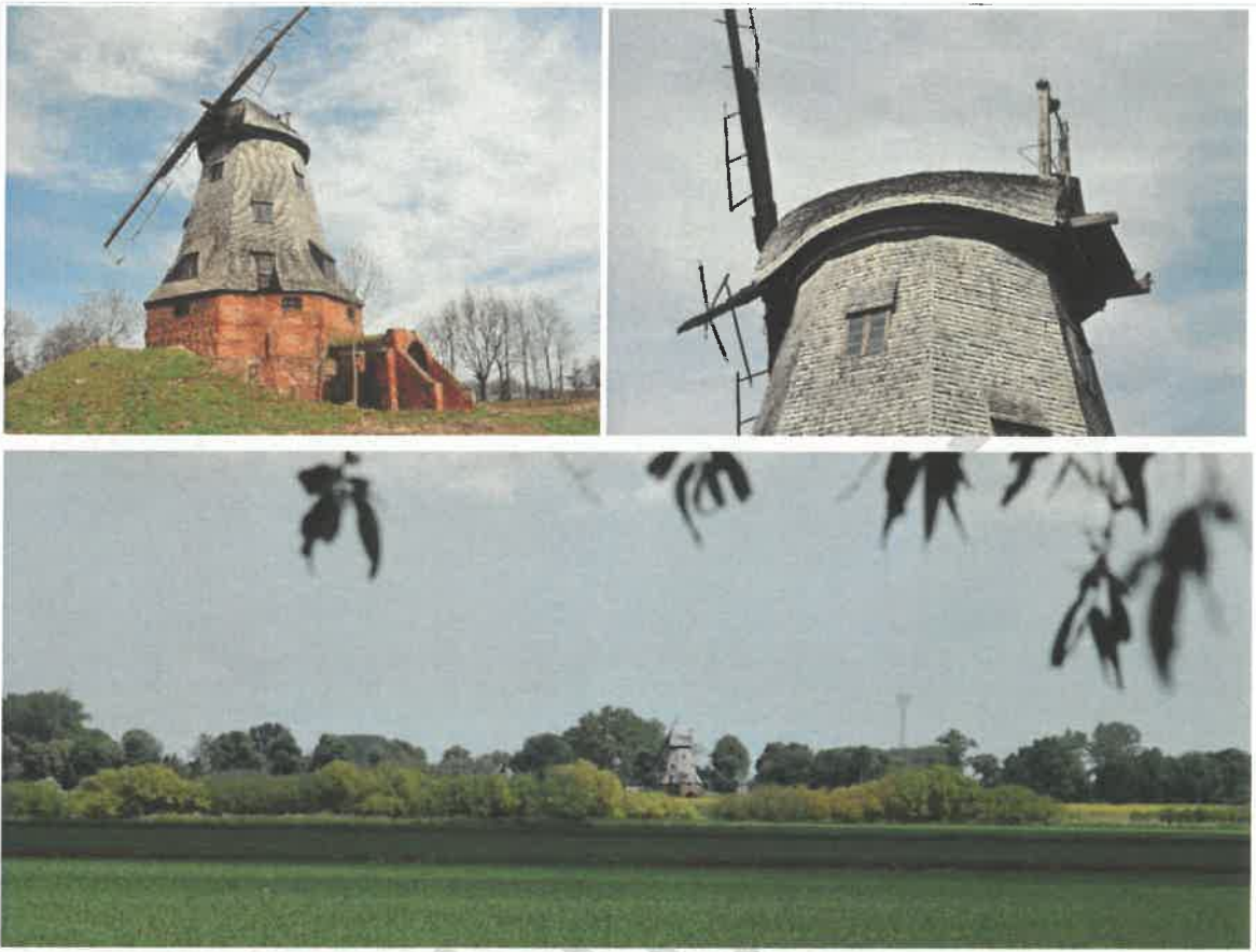
Fot. 11.; fot. 12.; fot.13.: Zachowany wiatrak typu holenderskiego w Palczewie widziany z bliska (po prawej, u góry detal pokrycia i zwieńczenia wieży) i z okolic zagrody Boręty 61
