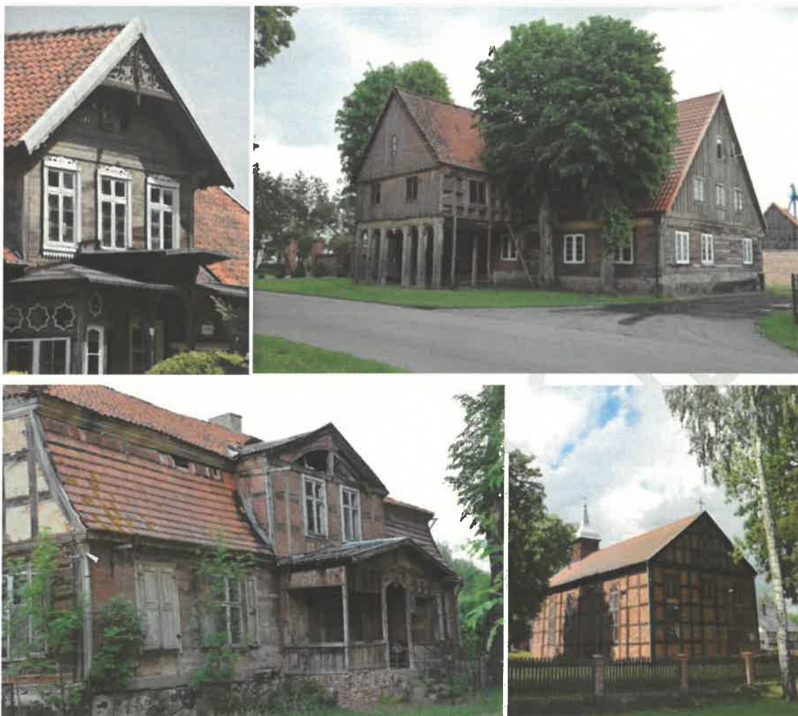
Fot. 16.; fot. 17.; fot. 18.; fot. 19.: Obiekty o największym znaczeniu dla krajobrazu priorytetowego, od góry, od lewej: dom Palczewo 12, dom podcieniowy Nowa Cerkiew 13, dwór drewniany Nowa Cerkiew 28/29, kościół pw. św. Katarzyny Boręty
