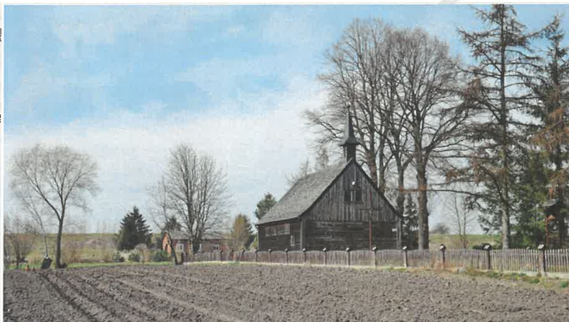
Fot. 9. Palczewo kościół drewniany widziany z ulicy, przedpole widoku- niewielkie pole uprawne, w tle wał przeciwpowodziowy
